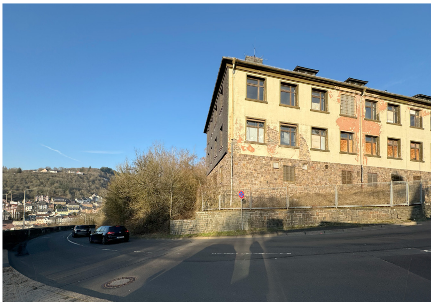
Blick von Westen auf das Bestandsgebäude entlang der Hohlstraße
