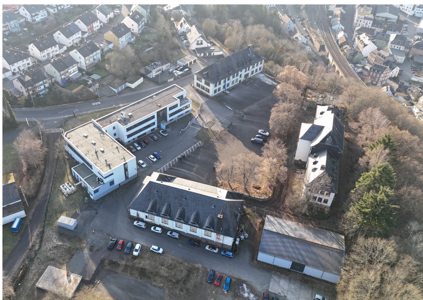
Drohnaufnahme von Osten auf die Bestandsgebäude und die Fernleitungs-Betriebsgesellschaft mbH
