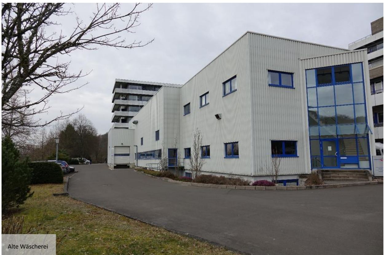
Blick von Südosten in das Plangebiet mit dem bestehenden Klinikum im Bild
