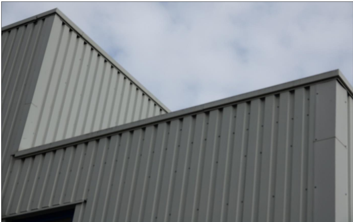
Abb. 11: Blechverkleidung an der ehem. Wäscherei
