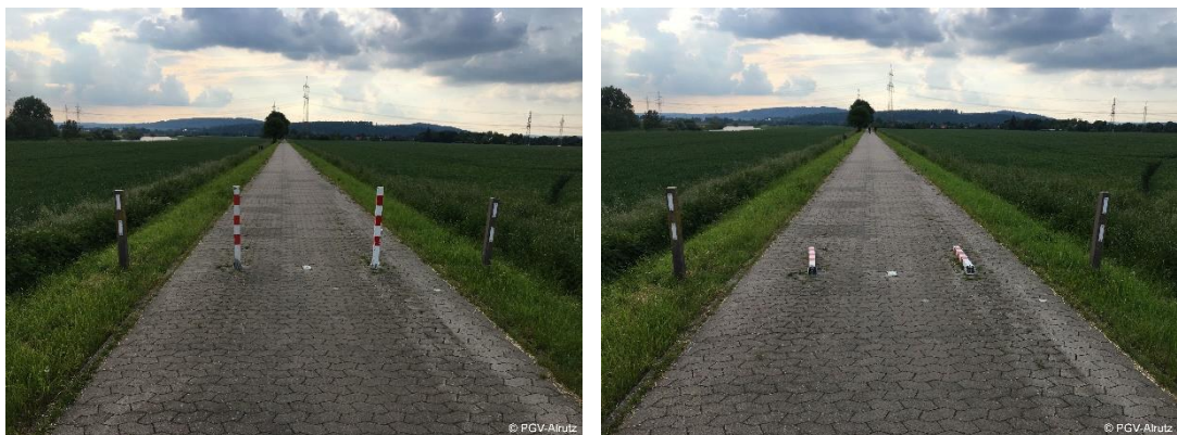
Abb. 5-56: Umklappbare Poller in hoch- und runtergeklapptem Zustand (Weserradweg, bei Hameln)
