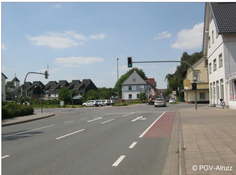
Abb. 5-18: Vorbeifahrstreifen in einer signalisierten Knotenpunktzufahrt (Bielefeld)
