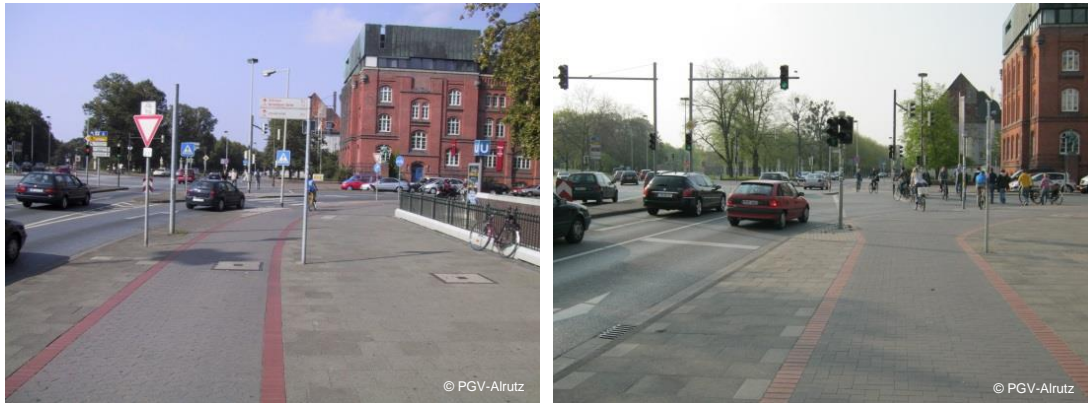
Abb. 5-19: Rückbau und Signalisierung eines konfliktträchtigen freien Rechtsabbiegefahrstreifens in Hannover (links vorher, rechts nachher)
