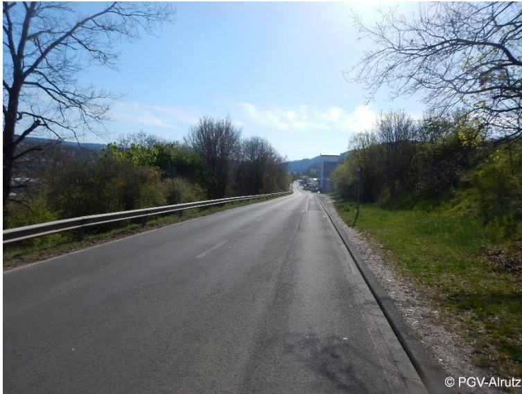
Abb. 5-53: Industriestraße (zwischen Industriestraße (Kesselgraben) und Michelswiese 11) Radverkehr im Mischverkehr bei Tempo 50
