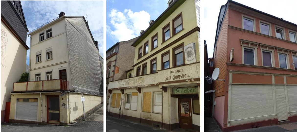
Abbildung 19 Leerst  nde an der zentralen Achse (Beispiele): v.l.: Wasenstr. 22, Wilhelmstr. 1, Wasenstr. 9; Fotos BBP
