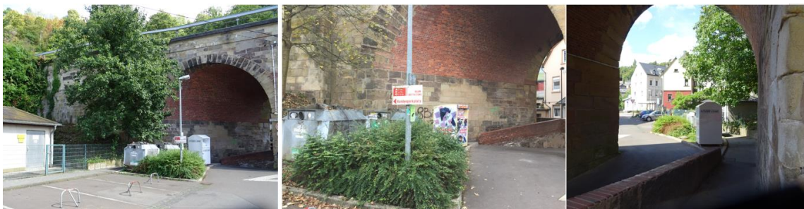
Abbildung 38 Hoher Handlungsbedarf im Umfeld des Viadukts
