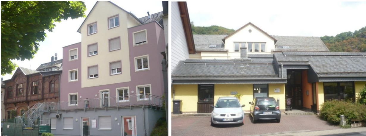
Abbildung 18 Foto links: Stiftung Kreuznacher Diakonie, Amtsstraße / Kasinostraße, rechts: KiTa St- Walburga, Ritterstraße 4-6
