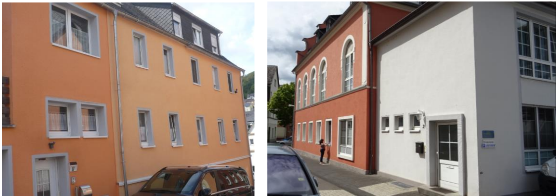
Abbildung 11 Gebäude im Heckweg und in der Kasinostr. ohne oder mit geringem sichtbarem Bedarf.
