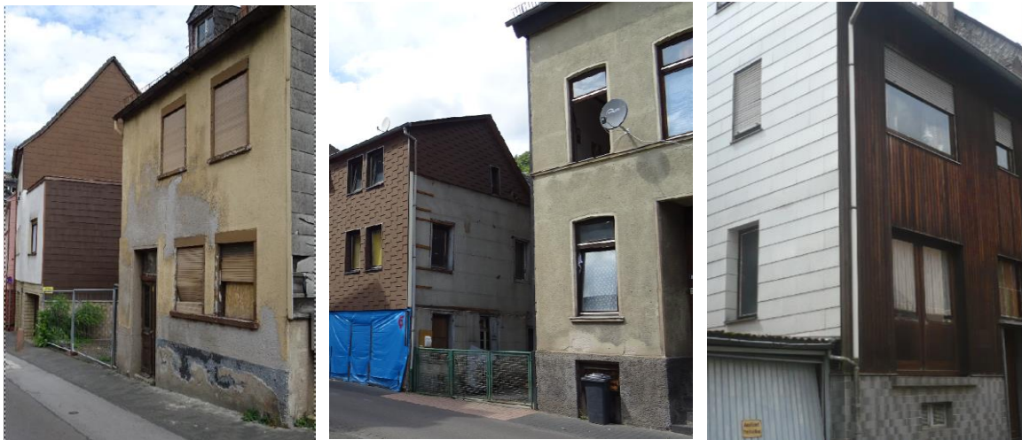
Abbildung 13 Gebäude in Wasenstr., Wilhelmstr und Ritterstr. mit sichtbar hohem Bedarf
